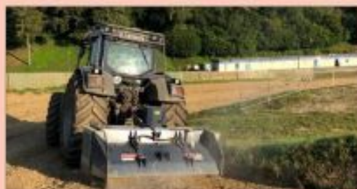
Les engins sont à l'ouvrage sur le circuit. Photo ER/DR
